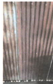
Foto 2: CUBIERTA DE LAMINA
