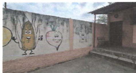
Foto 4: PINTURA EN MUROS INTERIOR Y EXTERIOR
