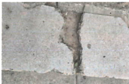
Foto 5: LOSA DE PATIO
